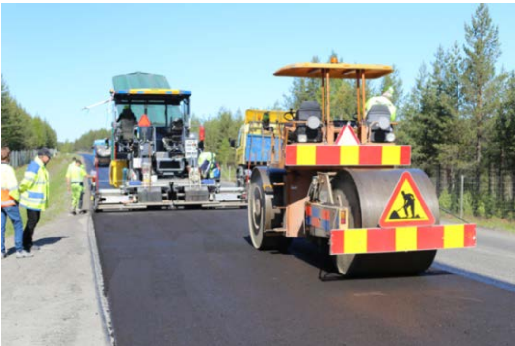
Figur 15 – Utläggning fullskaleförsök Base 22
