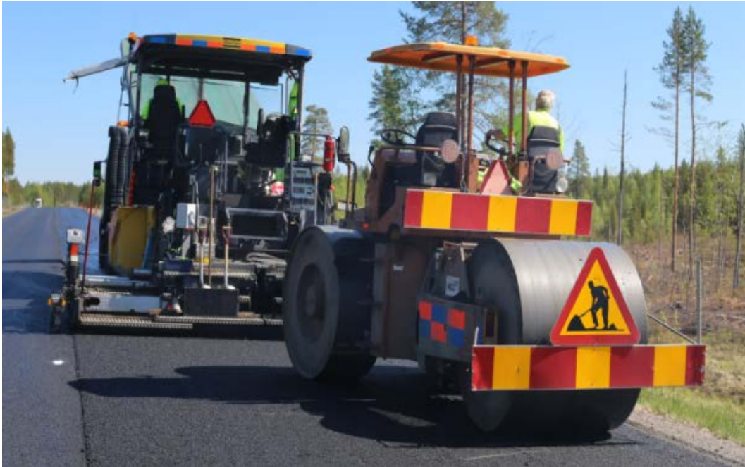
Figur 14 - Utläggning AG 22 NCC Green (referens)
